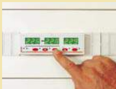
Tensiones de fase (RN-SN-TN) Tensiones de línea (R-S-T)
