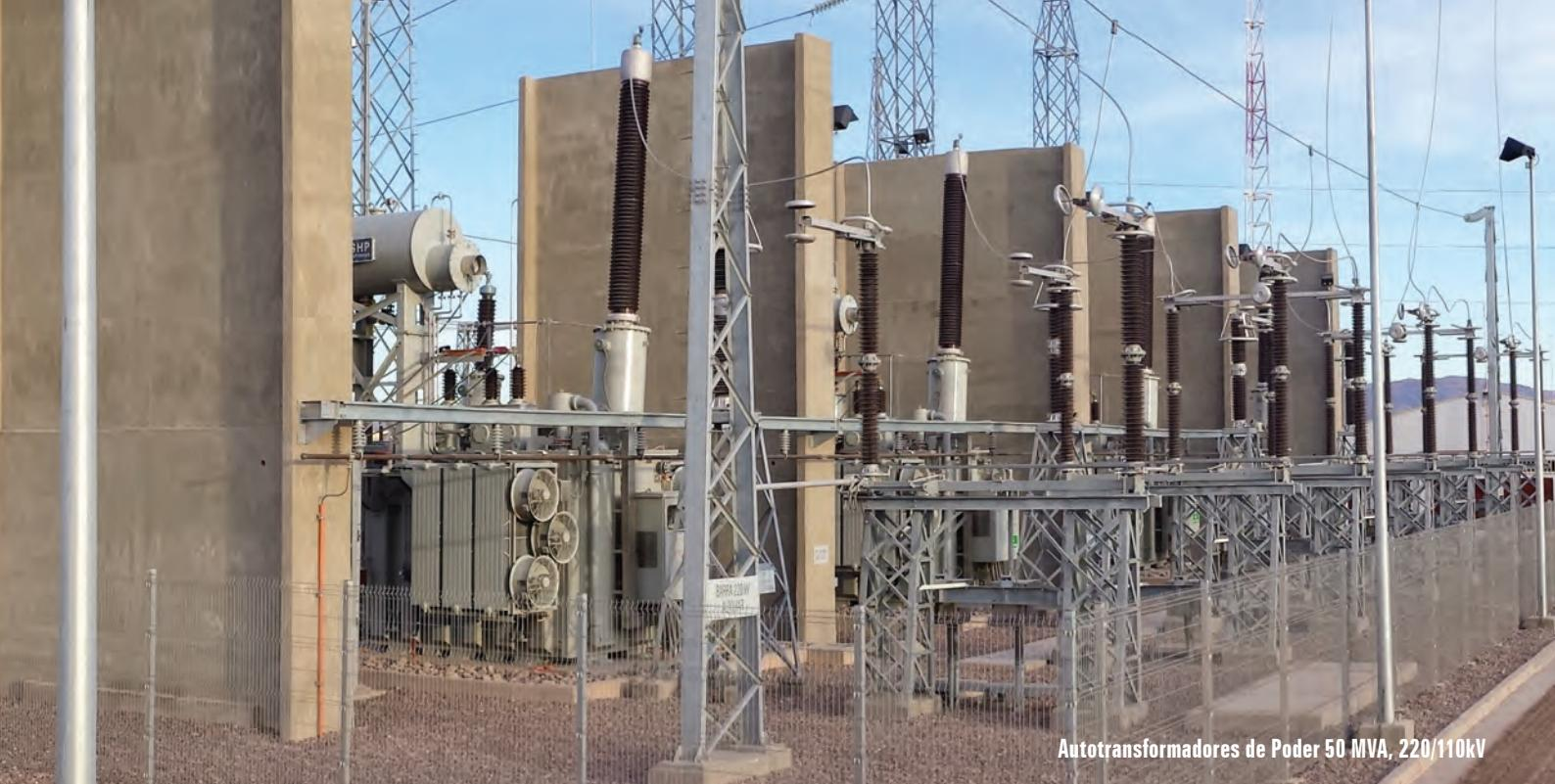
**Autotransformadores de Poder 50 MVA, 220/110kV**
