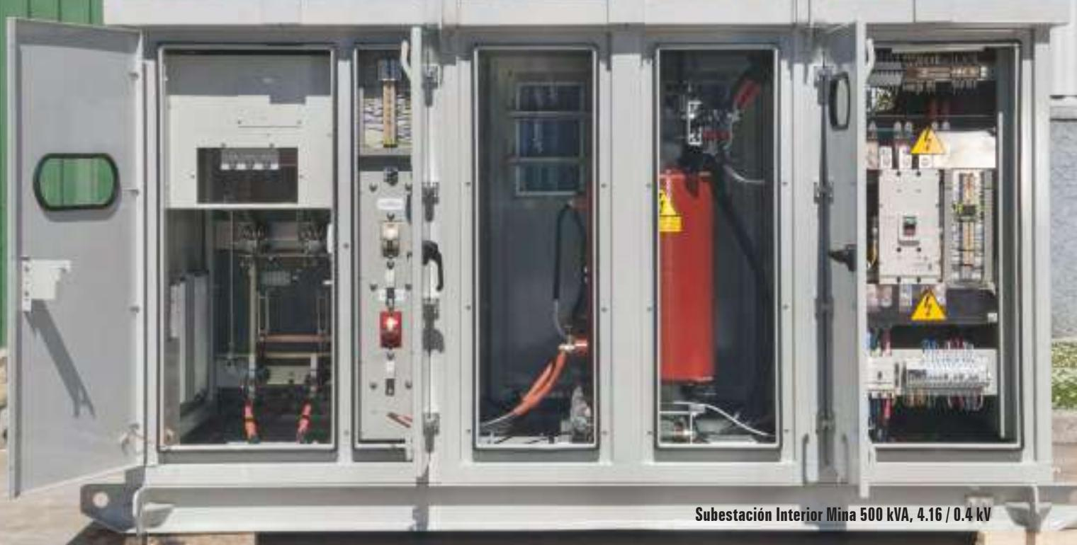
Subestación Interior Mina 500 kVA, 4.16 / 0.4 kV
